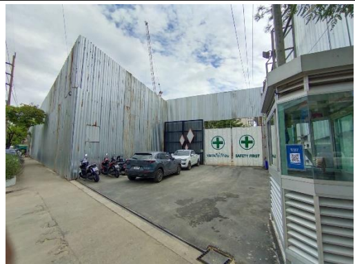
รูปที่ 2 รั้วทึบเมทัลชีท (Metal Sheet) รอบพื้นที่โครงการ
