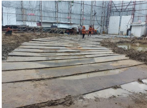
รูปที่ 11 แผ่นเหล็กทางเดินรถในโครงการ
