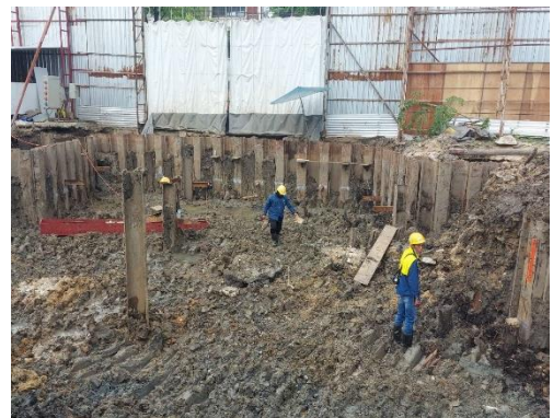
รูปที่ 7 ติดตั้ง Sheet Pile
