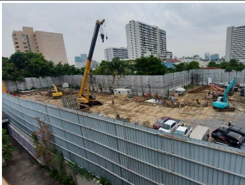
รูปที่ 2 รั้วทึบเมทัลชีท (Metal Sheet) รอบพื้นที่โครงการ
