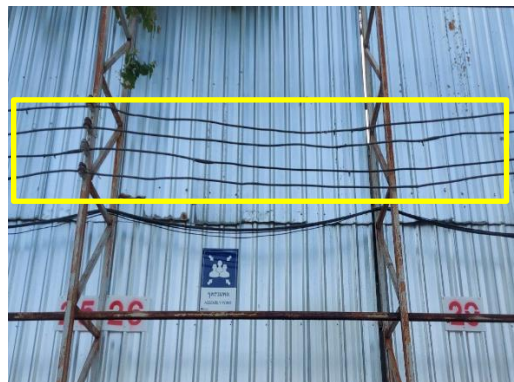
รูปที่ 8 ติดตั้งสเปรย์ละอองน้ำ
